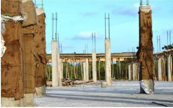
Inzwischen werden auf der Werkstatt-Baustelle die Querträger zwischen den Säulen gegossen.
